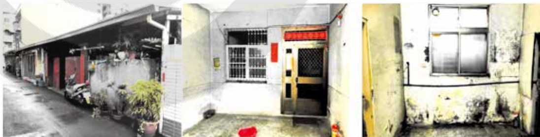
圖10、案例一施工前照片 （圖片來源：藹香設計室內裝修有限公司提供）
