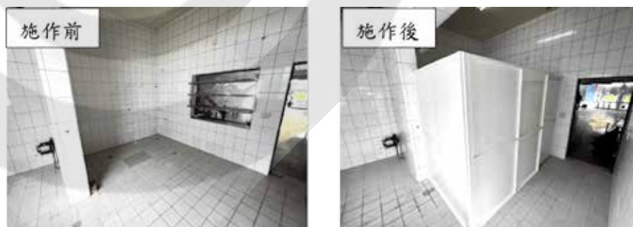
圖5、隔間裝修實例照片
