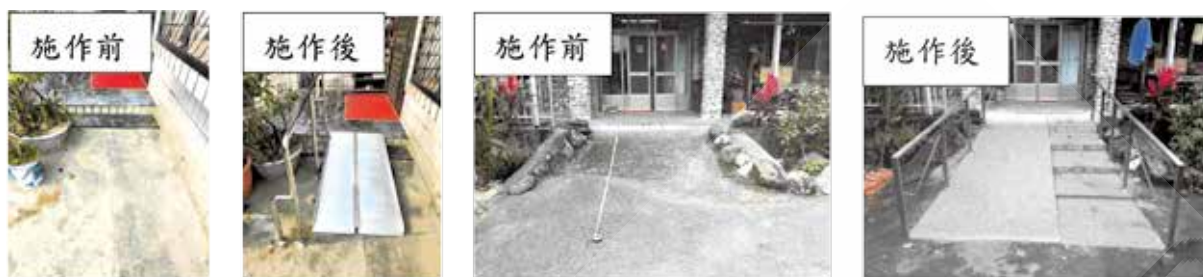
圖3、高低差處理及扶手安裝實例照片
